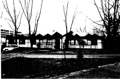
▼ Pohľad z Ďumbierskej ulice na budovu hotela - severozápadný.
